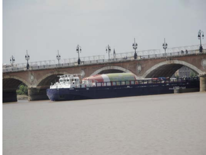
Figure 12. Le passage des éléments de l'A380 sous le pont de pierre
