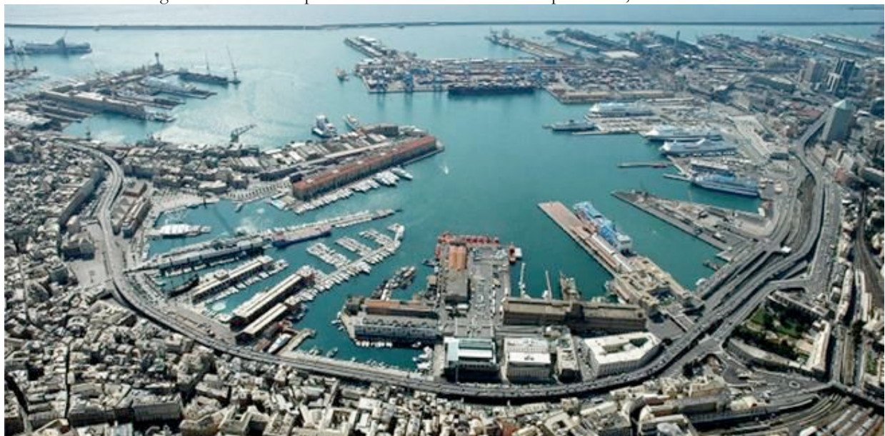
Figura 2. La zona del porto antico e il tracciato della Sopraelevata, tra città e mare
