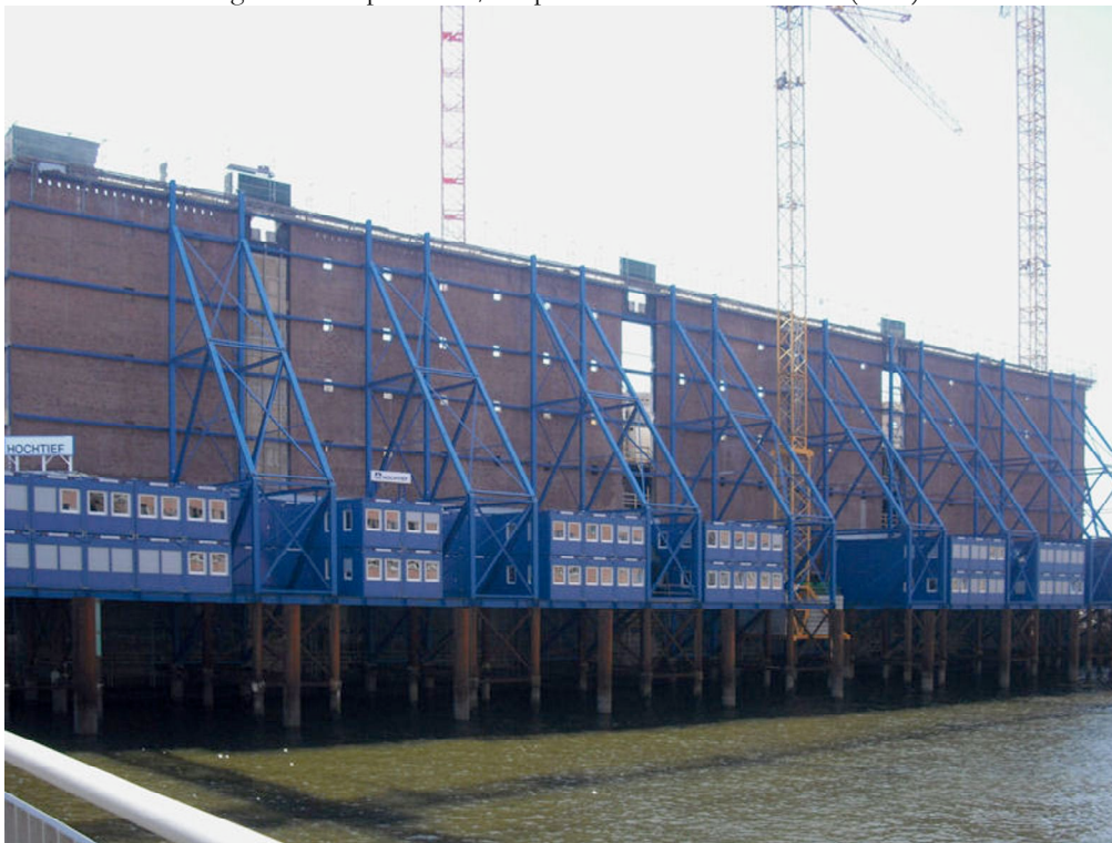
Figura 2. Kaispeicher A/Elbphilharmonie in costruzione (2008)
