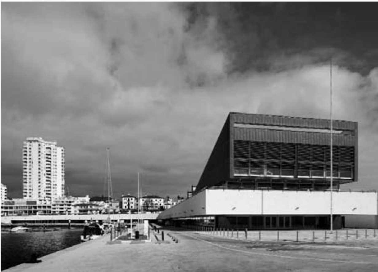
Vista desde o molhe exterior existente do porto Vista ao nível do cais para terra, com cidade ao fundo View from the existing external dock View of the building with the city in the background
