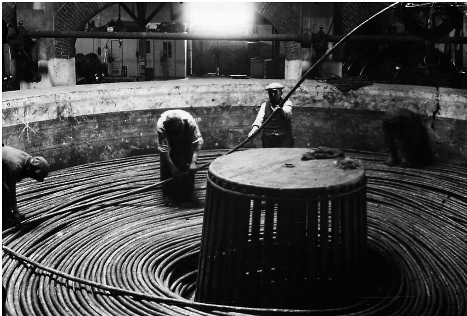
Amphibia, entre réel et virtuel: remplissage d'une «bobine de fil» à l'usine de La Seyne sur mer avant embarquement et pose en mer par les navires cabliers du port de Brégallion, rade de Toulon, début XXème. (Archives AACSM Association des Amis des Câbles Sous-Marins, La Seyne sur mer, Fonds MALTAE)
