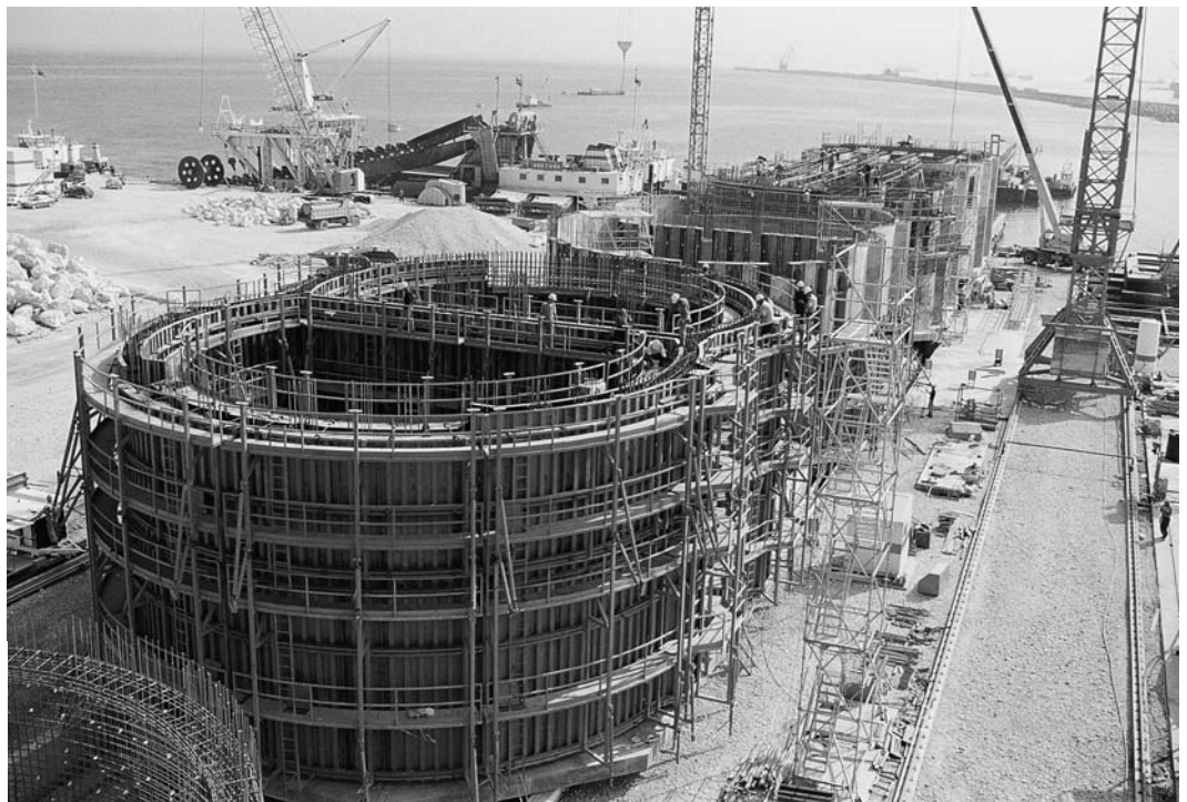
Sea defense caisson under construction on slipway Waterfront District: model view from northeast Compuerta flotante de la defensa del mar en construcción Waterfront del Distrito: vista del modelo desde el noreste
