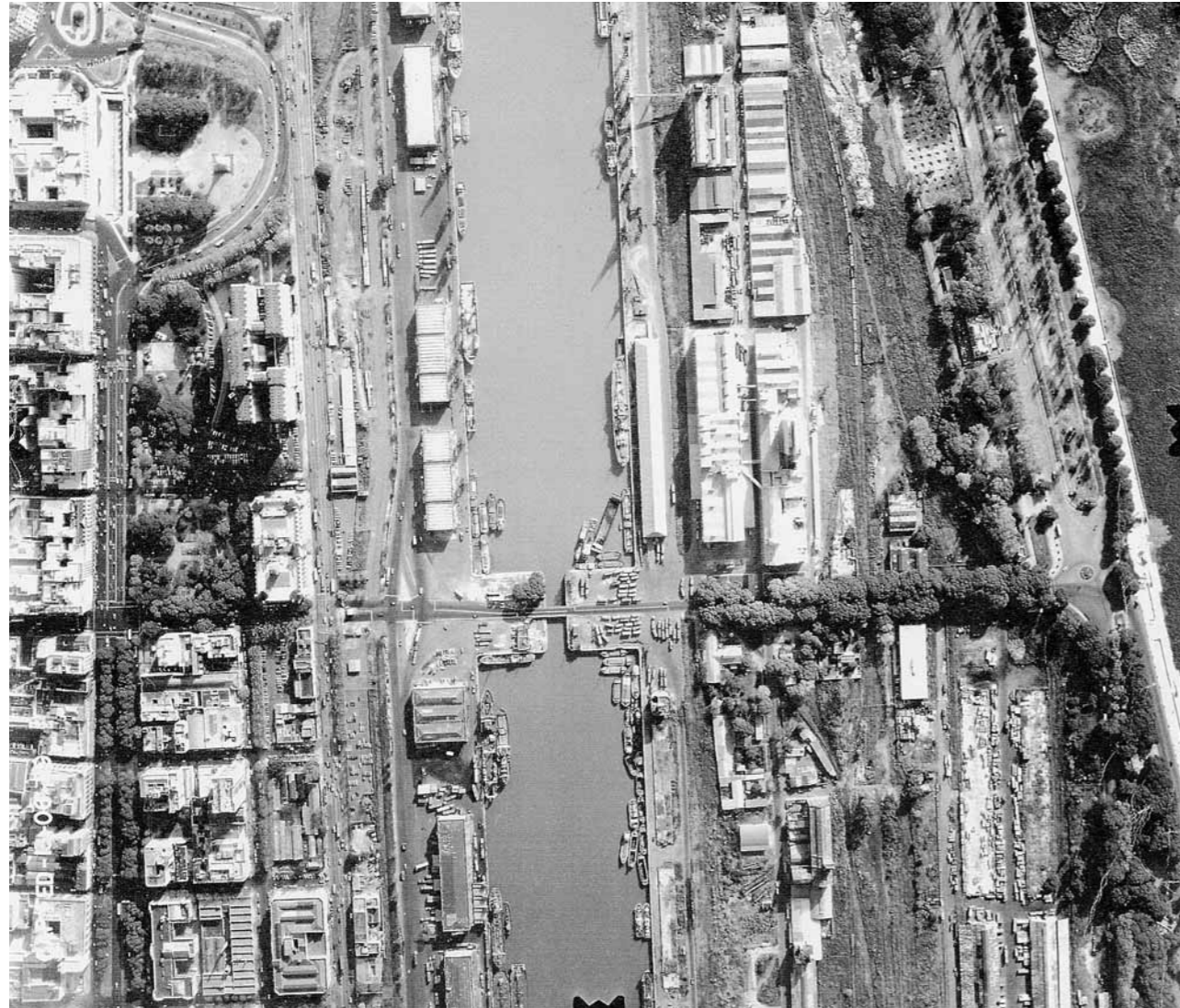
Foto zenital del área de intervención: Casa de Gobierno (arriba a mano izquierda), dique 1, Costanera Sur y reserva ecológica (aprox. 1978) Zenithal view of the site: Casa de Gobierno (on the top left), pier 1, Costanera Sur and the ecological reserve (approx. 1978)
